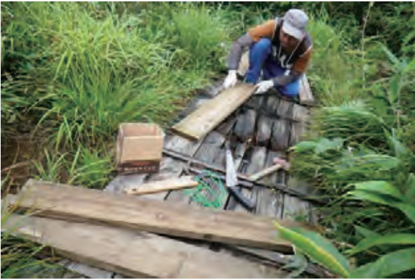
図11 傷んだ歩道を修理する。
